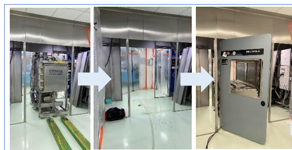
Découpes nécessaires pour intégrer l'autoclave dans le mur Getinge
