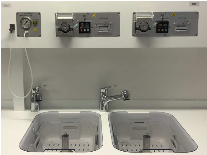
Paillasse semi-automatisée (double pompe) dédiée au lavage ES
